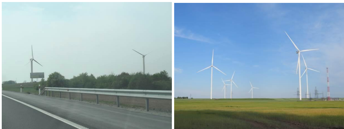
Pav. 54. Dvi mažosios (netaisyklingų proporcijų) vėjo elektrinės prie magistralinio kelio A1 (kairė nuotrauka). Didelių erdvinių parametų proporcingos elektrinės (dešinė nuotrauka) Jonavos rajone
