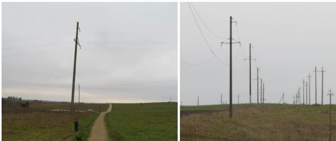
Pav. 2.40 Esamos orinės aukštos įtampos elektros perdavimo linijos Sprūdės piliakalnio papėdėje
