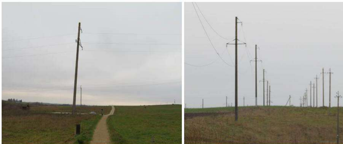
Pav. 2.28 Esamos orinės aukštos įtampos elektros perdavimo linijos Sprūdės piliakalnio papėdėje
