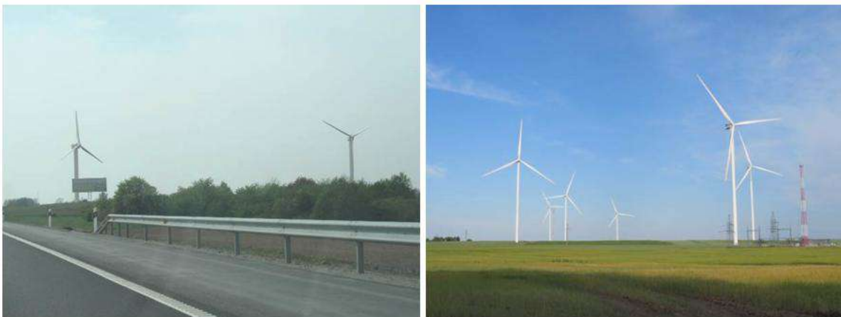
Pav. 2.29 Dvi mažosios (netaisyklingų proporcijų) vėjo elektrinės prie magistralinio kelio A1 (kairė nuotrauka). Didelių, proporcingų erdvinių parametų elektrinės (dešinė nuotrauka) Jonavos rajone
