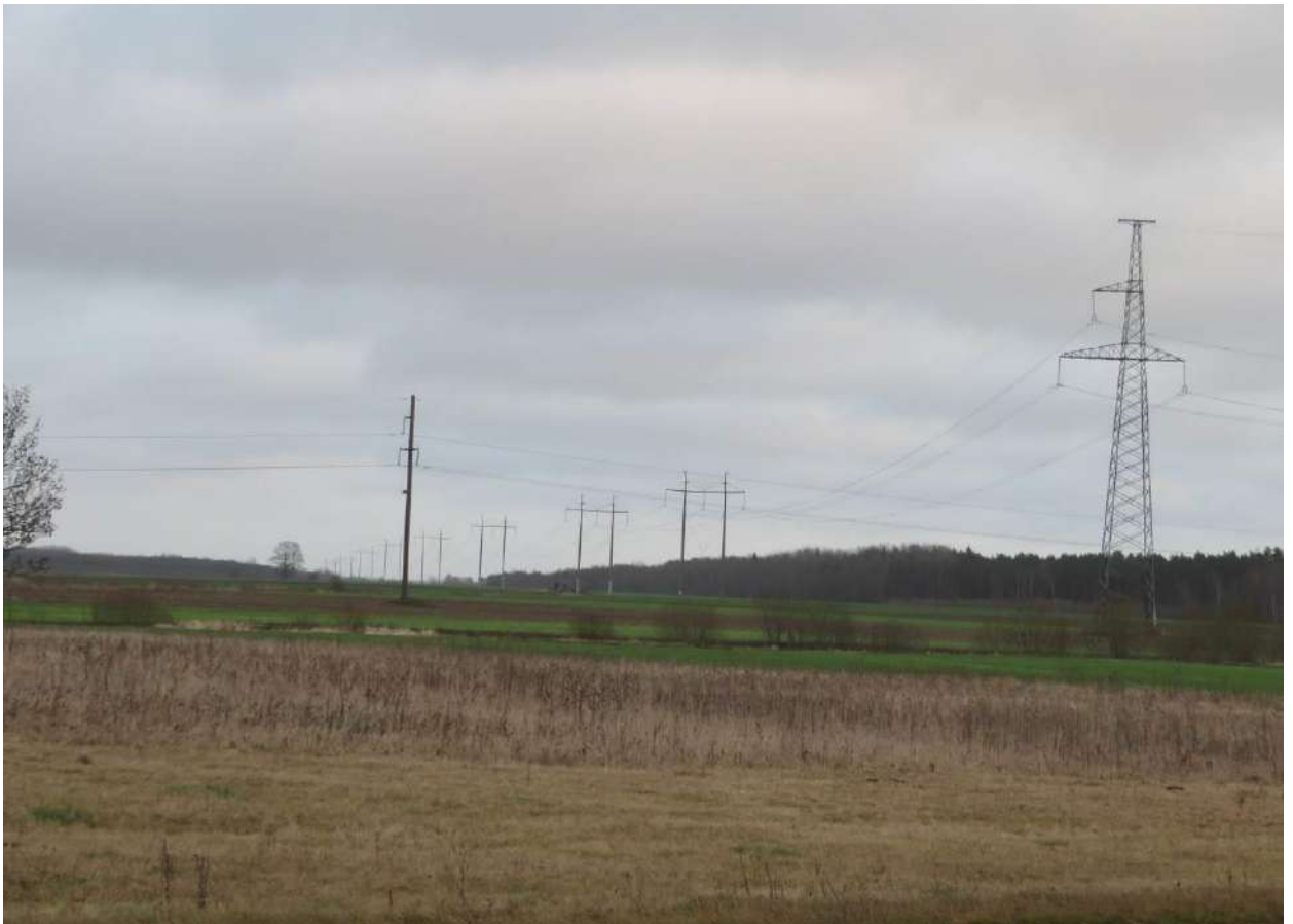
11 pav. Fotofiksacijos vieta nuo kelio Kruopiai – Šiauliai (nr. 154). Nuotraukoje matosi vėjo elektrinių plėtros teritorijoje esančios 110 kV ir 330 kV orinės elektros perdavimo linijos
