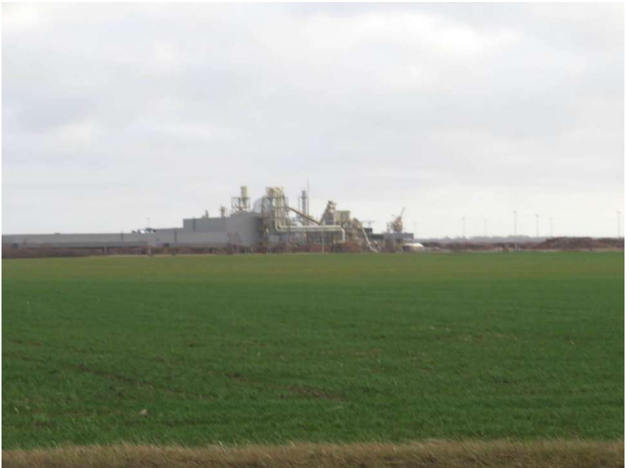
54 pav. Fotofiksacijos vieta nuo kelio Naujoji Akmenė – Seda (nr. 156). Nuotraukoje matomas naujai pastatytas medžių plokščių gamybos ir sandėliavimo statinių kompleksas
