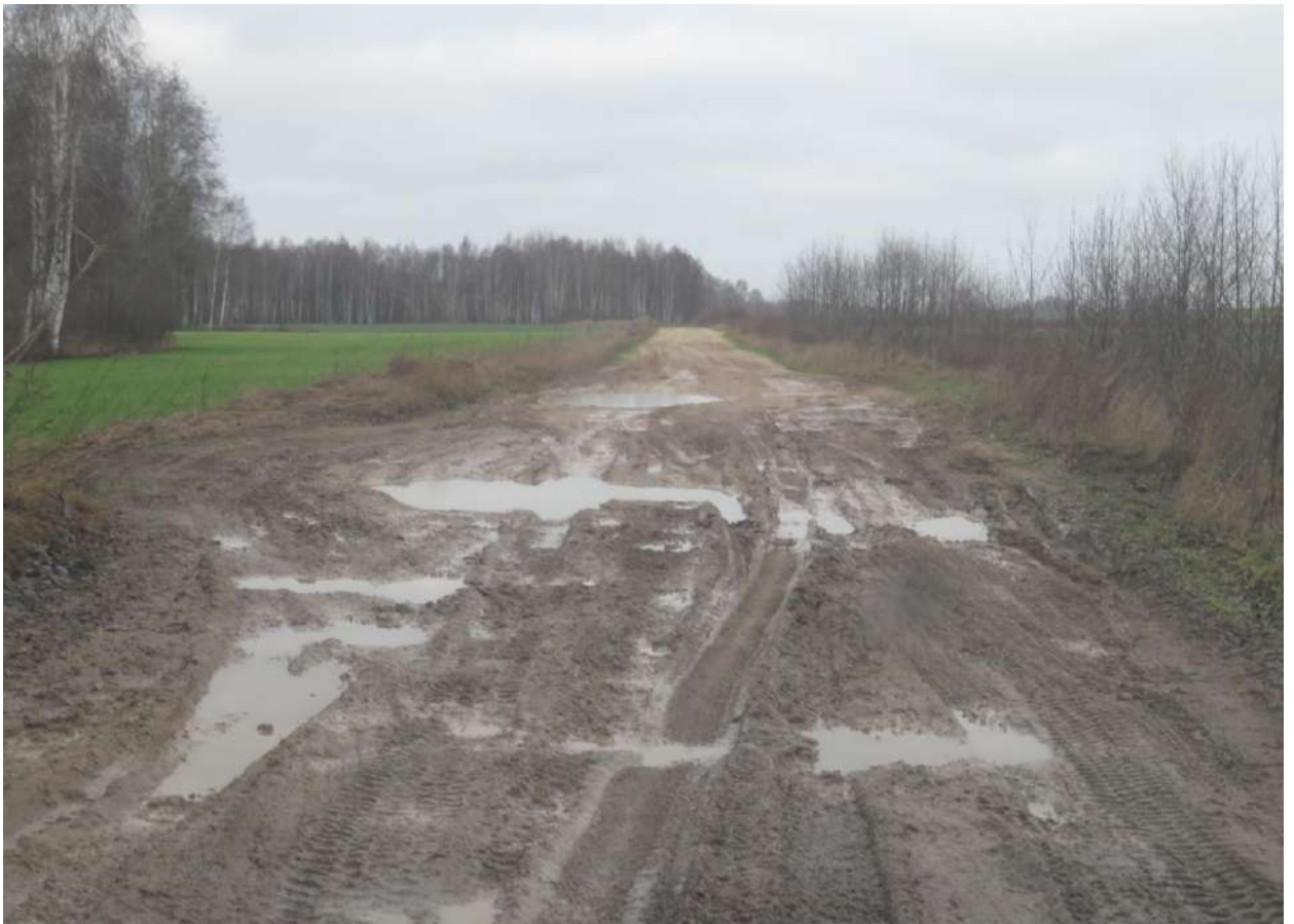
16 pav. Kai kurios vietinių kelių atkarpos sunkiai pravažiuojamos. Vykiant vėjo elektrinių statybą, būtina atnaujinti kelio atkarpas
